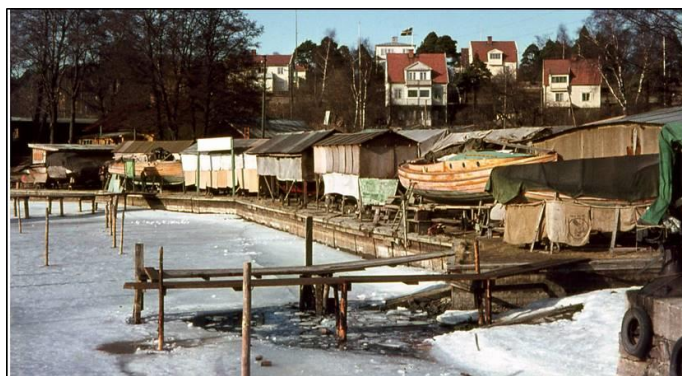
Gamla hamnen med stolpar av granar och strandskoning av impregnerat virke
