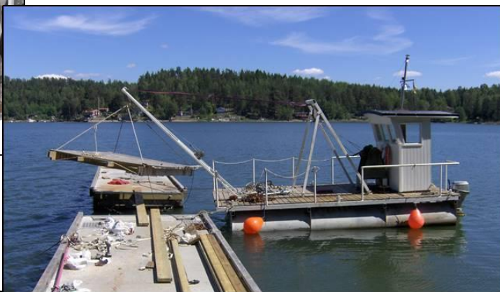
Starke och nya betongbryggor på Radön
